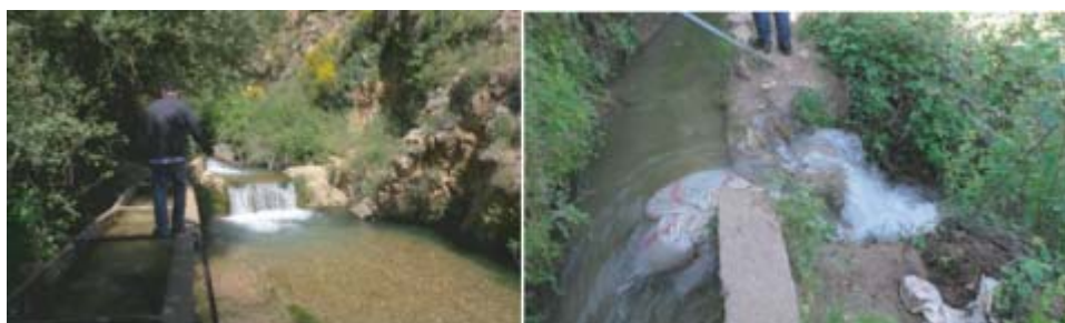
A) La source de Qoubb Elias. Les deux embranchements sont séparés par un muret. B) Des sacs de sable sur des bouts brisés du muret altèrent la répartition de l'eau entre les canaux de distribution.
